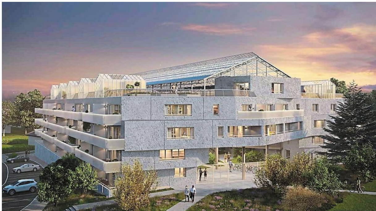
La nouvelle résidence Utopia est située en bordure du parc de la Herverie à Bruz. Elle vient d'être livrée.
