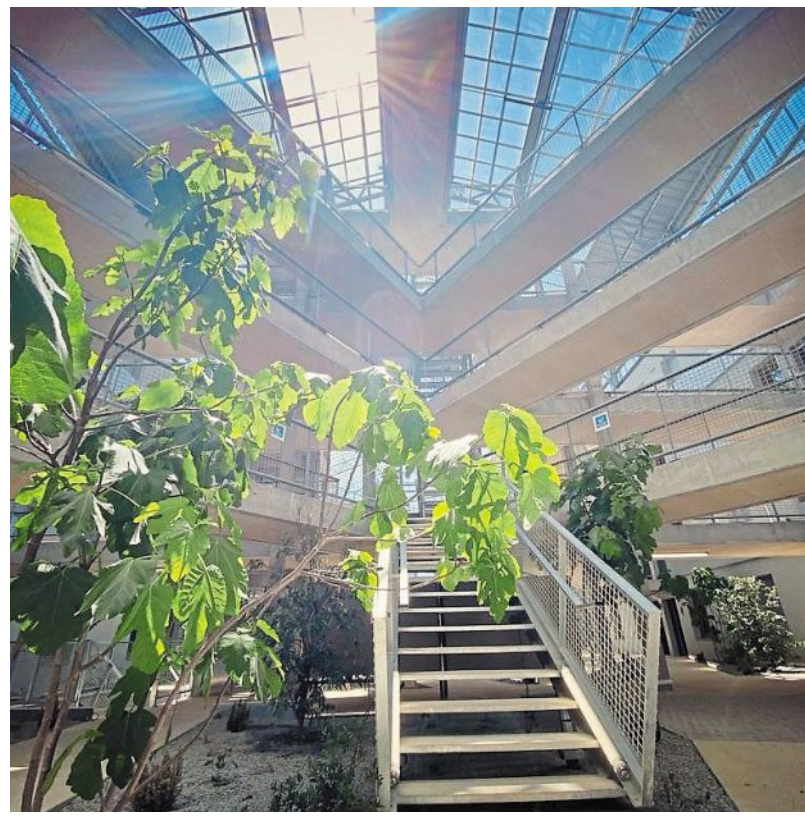
Les logements profitent d'une grande serre traversante de 1 000 m 2 avec 4 000 plantations.
